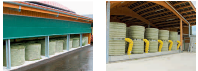
Abb. 8: Links zweireihige Anlage mit Betonkanal und Rollplane an der Gebäudeaussenseite; rechts Anlage mit fixem Blechkanal und Zwischenringen.
