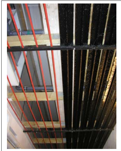
Abb. 4: Parallel angeordnete Wärmeleitprofile im Zentralgang, links noch zu sehen: 6 Wasser führende Kupferrohre, kurz vor dem Aufpressen der Profile
