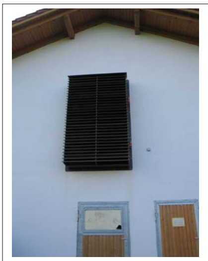
Abb. 3: Nordseitiger Lufteintritt in den Zentralgang des Stalles
