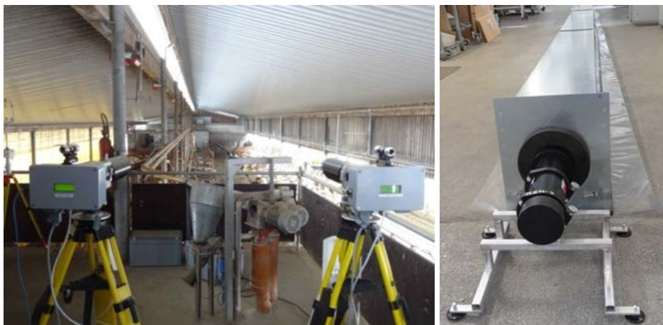
Ammoniakkonzentrationsmessung mit zwei „OP-TDLS“-Lasermessgeräten (Milchviehstall, LVFZ Almesbach) (links), Messtunnel und Reflektorkomponente zur Emissionsfrachtenbestimmung an Laufhöfen (rechts)
