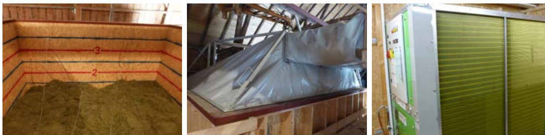
Eingelagerte Charge im Heustock (links), Abluftführungshaube auf der Trocknungsbox (Mitte) und Entfeuchter (rechts)
