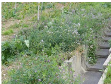
Abb. 3: Wasserabschlag mit vielfältiger Begrünung
