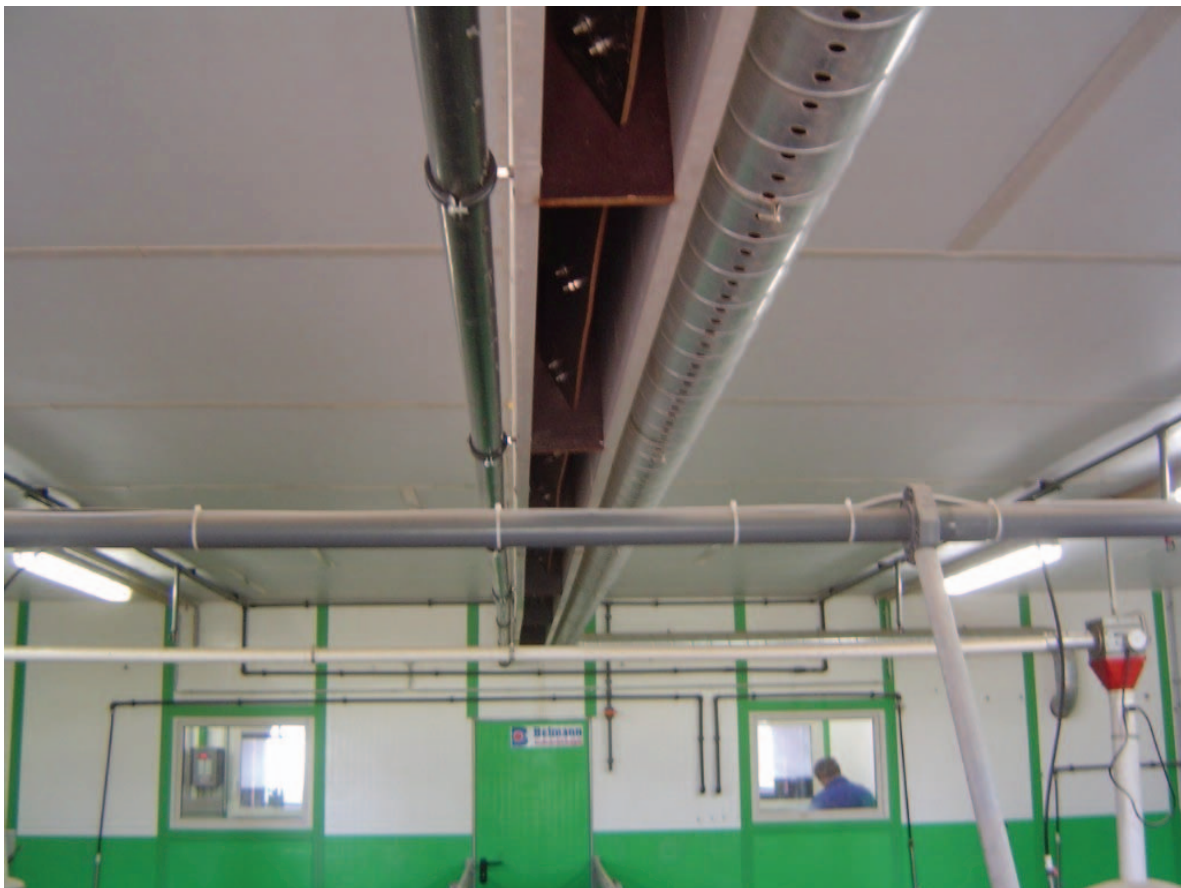
Abb. 5: Schlitz- oder Sturzlüftung mit Funktionsprinzip der Türganglüftung
