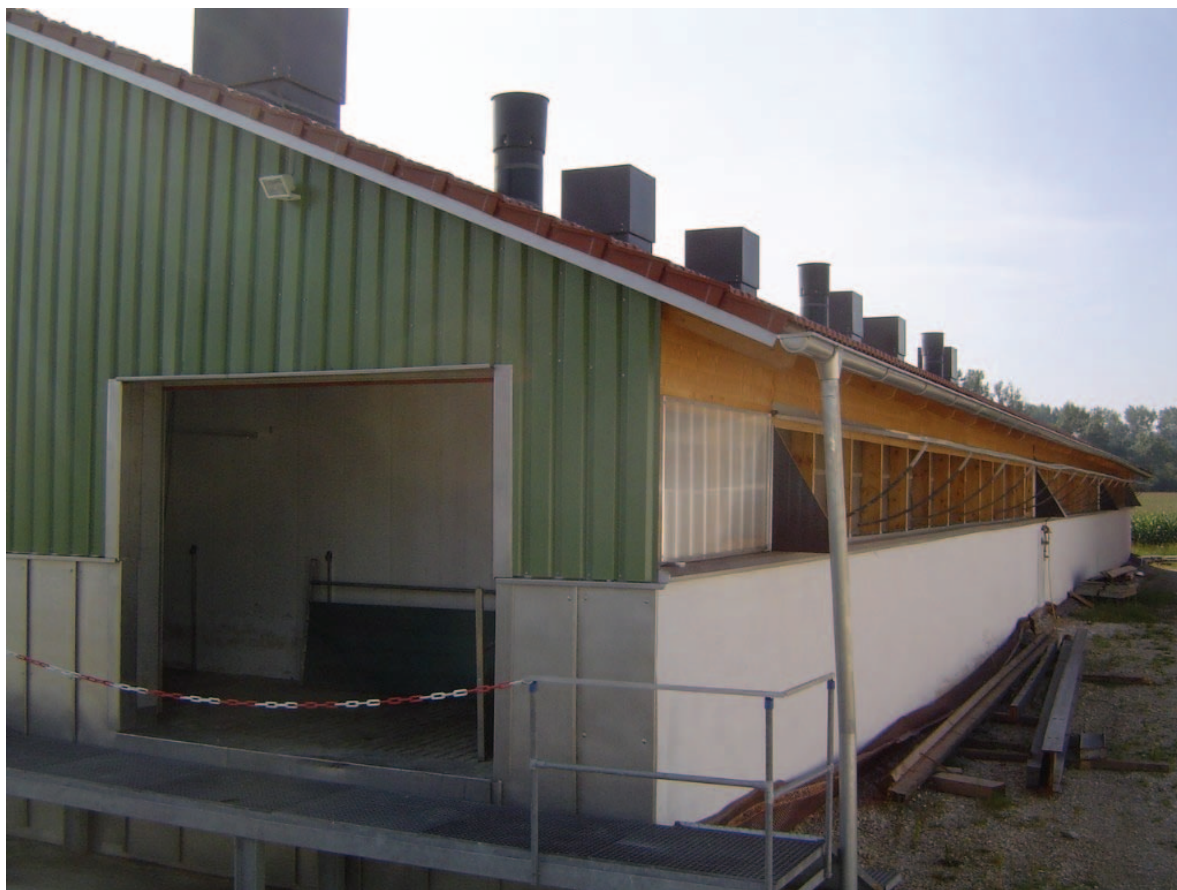
Abb. 6: Zur Energieeinsparung - Kombination aus Zwangslüftung und natürlicher Lüftung
