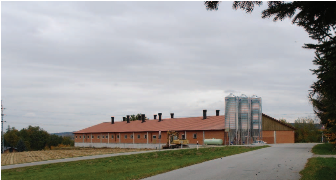
Abb. 3: Hoher Abluftaustritt im Firstbereich – von manchen Baugenehmigungsbehörden gewünscht
