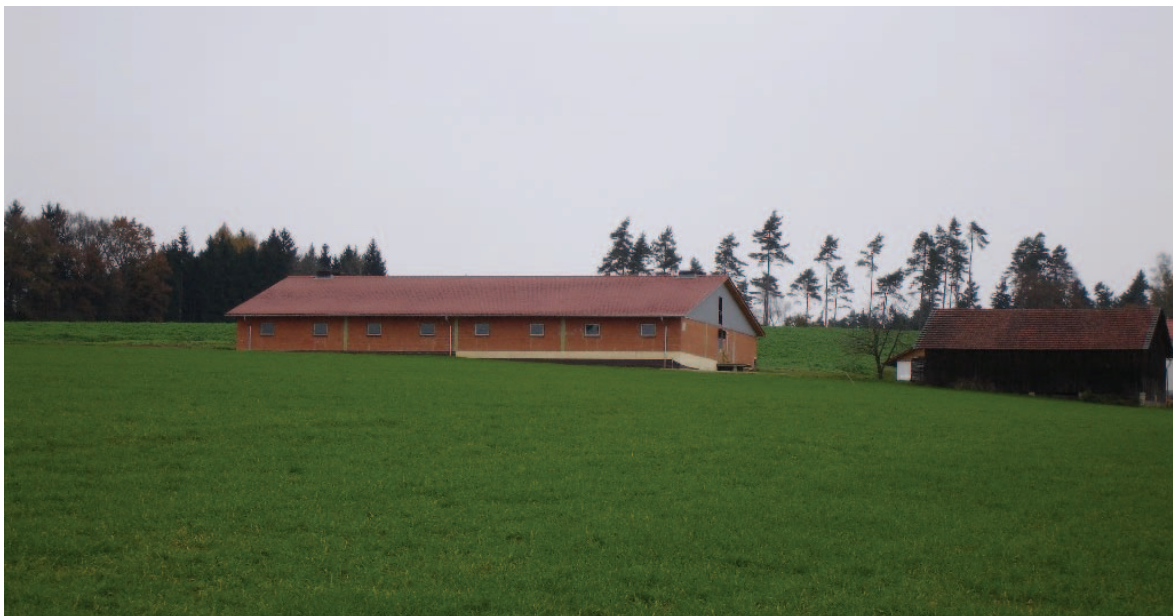
Abb. 4: Traditionelle Mauerwerksbauten mit Ringanker – von Landwirten oft bevorzugt
