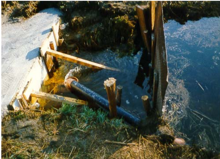
Abb.: Fertigstellung des Ablaufes mit einbetoniertem Kunststoffrohr
