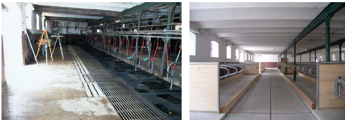
Umbau des alten Anbindestalls für Milchvieh zum Liegeboxenlaufstall für die Jungviehhaltung in Hübschenried – Situation vorher/nachher
