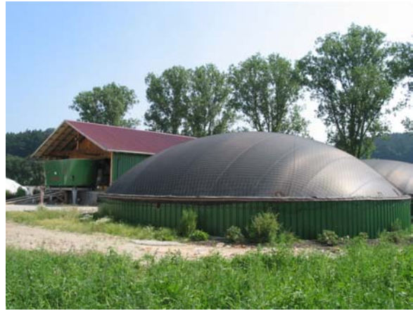
Praxisbiogasanlage: Fermenter (vorne), Dosierstation (hinten)
