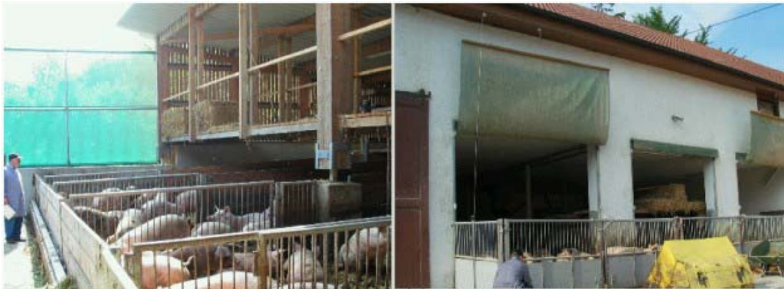
Neu gebauter Offenfrontstall für Mastschweine (li), Umbau einer ehemaligen Garage (re)
