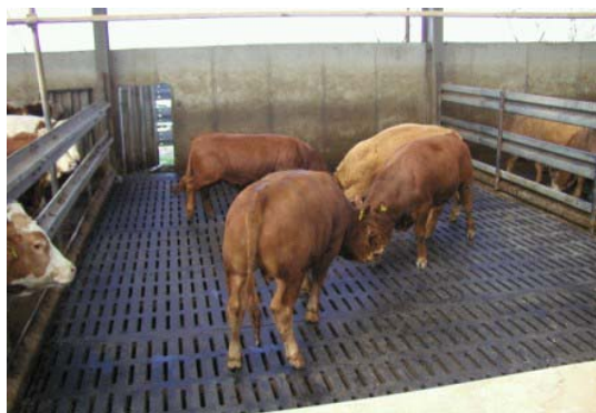
Mastbucht mit perforierter Gummiauflage
