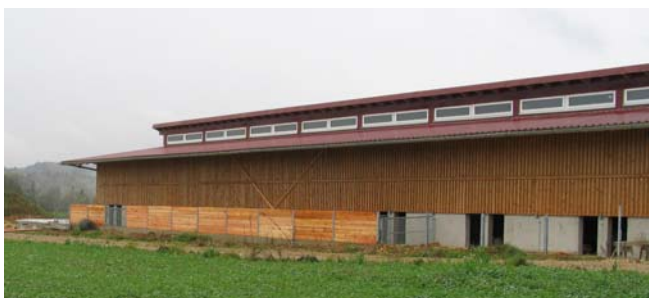
Ostansicht des Außenklimastalles (Bauphase)
