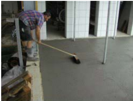
Besenstrich bei Mikrosilicabeton
