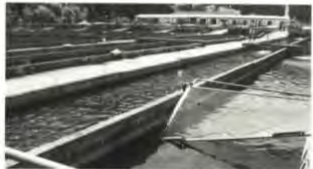
Bild 3: Fließkanalanlage der Fa. Slovryb a. s. in Biely Potok, im Hintergrund die Verarbeitungshalle
