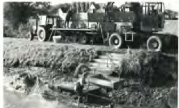
Die Abfischung von einsömmerigen Karpfen auf dem Betrieb Walter Jakob mit dem Bagger
