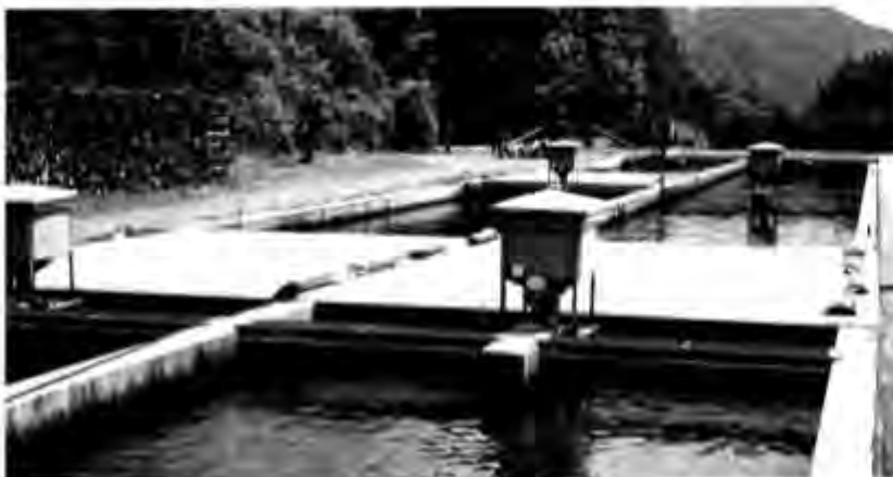
Bild 3: Fließkanalanlage der Forellenzucht Iglar
