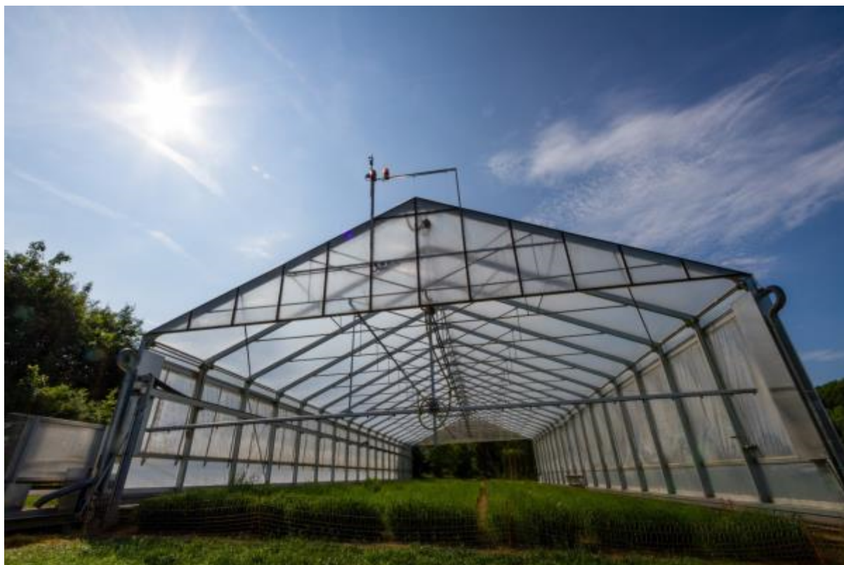
Abbildung 7 Das Rollgewächshaus der LfL. Das Rollgewächshaus fährt bei Regen automatisch über im Freiland angebauten Pflanzen und ermöglicht somit eine vollständige Kontrolle über die Bewässerung dieser Pflanzen. Foto: Tom Freudenberg.
