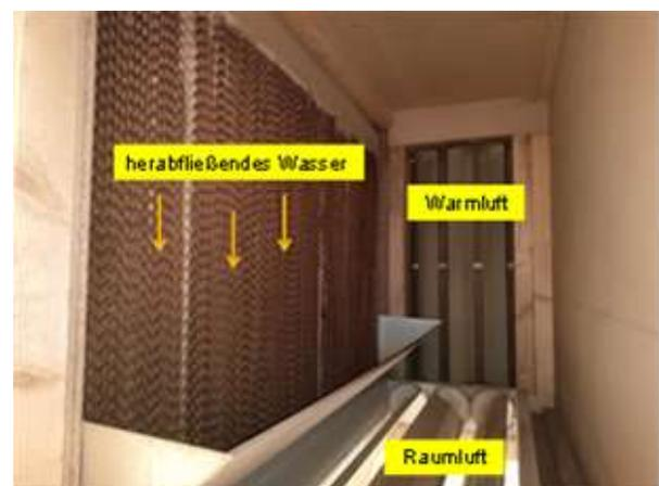
*Abb.: Kühlpad zum Einstellen der richtigen Belüftungsluft*
