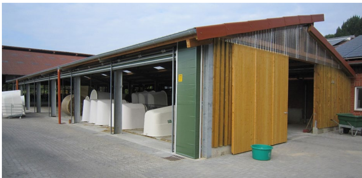
Abbildung 4: Ein überdachter Bereich, der in der kaltnassen Jahreszeit durch eine Jalousie verschlossen werden kann, bietet sehr gute Bedingungen für das Aufstellen von Einzelglus oder auch Kälberboxen. (Kunz)
