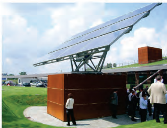
Redox-Flow Batterie (100 kWh / 10 kW) mit drehbarer Photovoltaik, Fa. Cellstrom und Younicos AG
