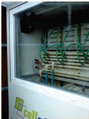
Redox-Flow Batterie (100 kWh / 10 kW) mit drehbarer Photovoltaik, Fa. Cellstrom und Younicos AG
