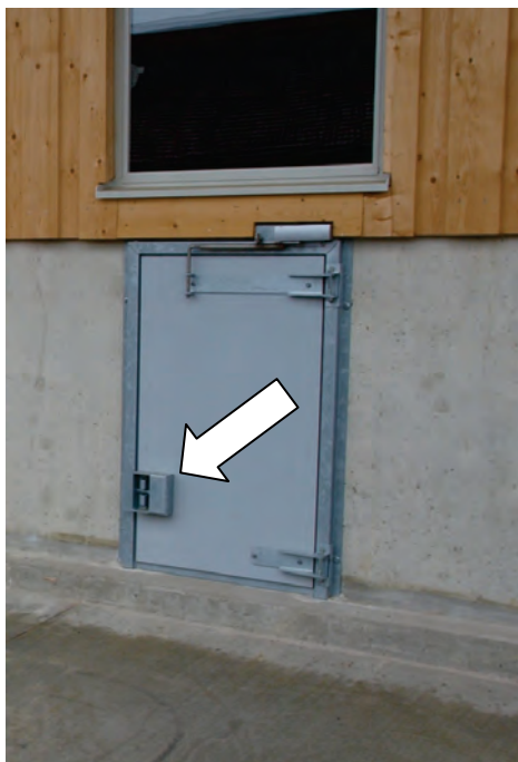
Abb. 3: Dicht schließende Auslauftür mit Rahmen, Schließmechanismus und „Griff“
