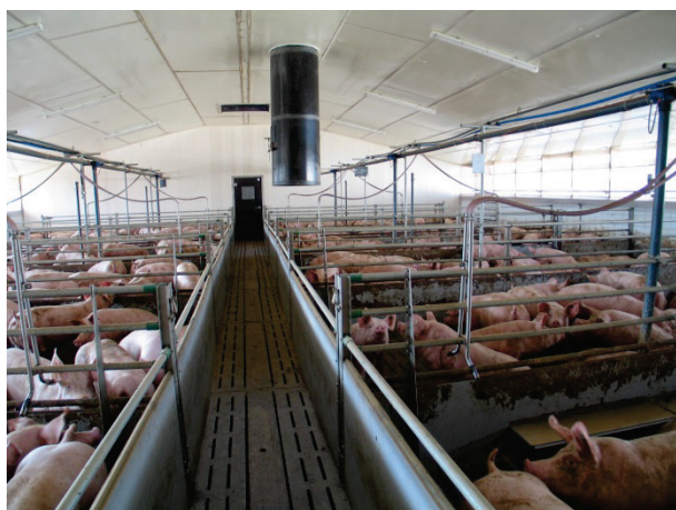
Abb. 3: Eine Ausrichtung der Buchten zwischen Kontrollgang und Außenwand sowie der Entmistungsachsen in Längsrichtung ist auch mit Vollspaltenboden möglich.
