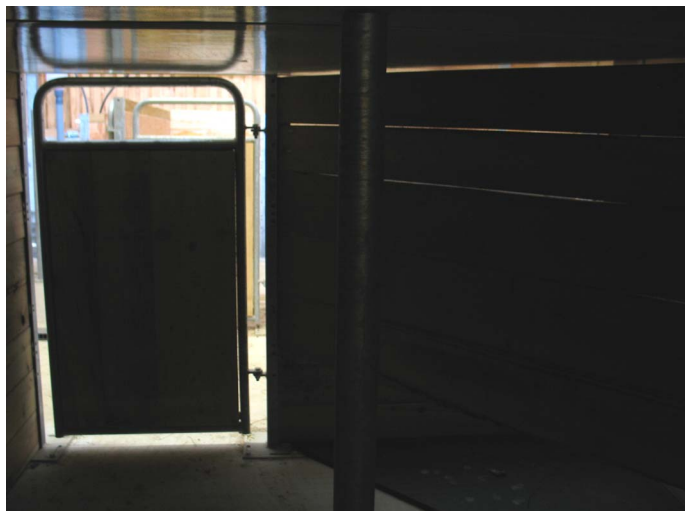
Abb. 26: Schlitze an der Zugangstür zum Liegebereich
