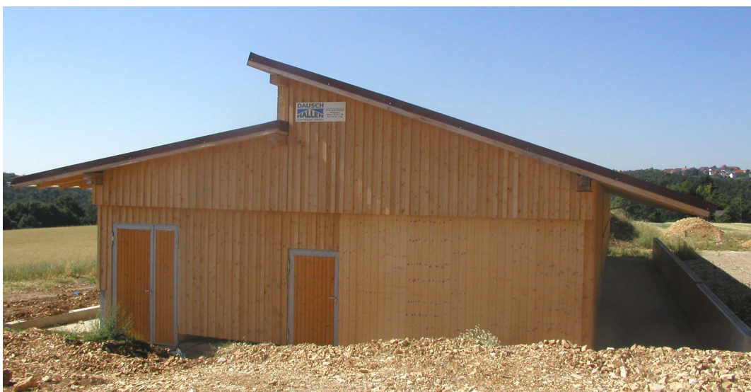
Abb. 7: Ansicht Giebelseite von Norden
