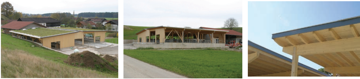
Abb. 5: Ansichten Stall von Nordosten, Nordwesten und Dachdetail
