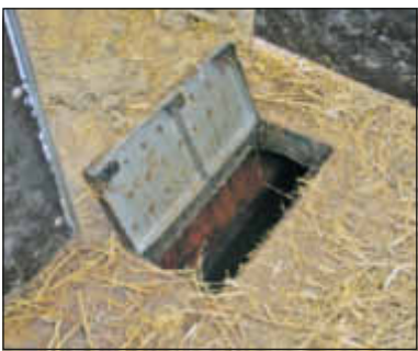
Der Festmist wird auf dem Betrieb Adam in einen Abwurfschacht geschoben und dann mit einer Spülleitung vom Stall in die Güllegrube befördert.
