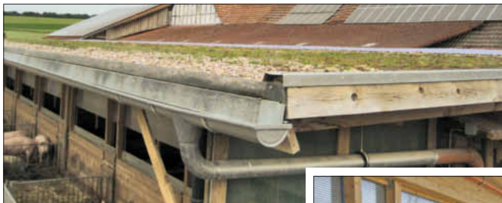
Die Außenwände des Mastbereichs haben verstellbare Fensterelemente aus Doppelstegplatten. Auf dem neu gebauten Trakt ist ein Gründach.
