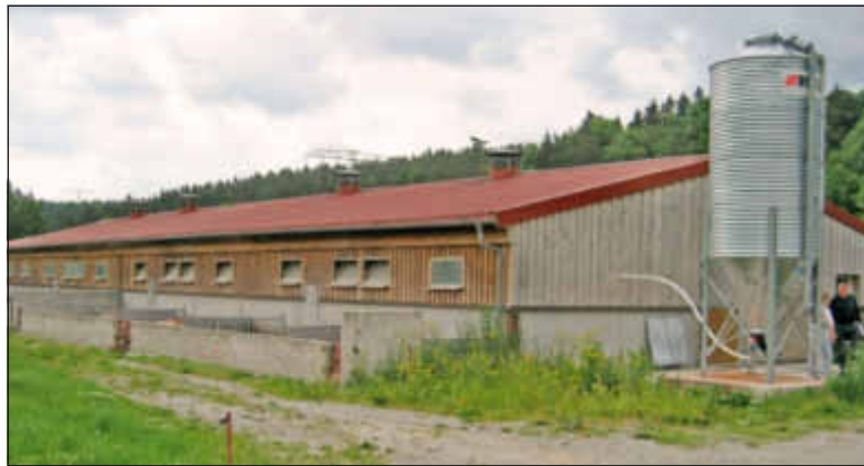
Der Ferkelaufzuchtstall des Ökozentrums Werratal wurde neu gebaut.
