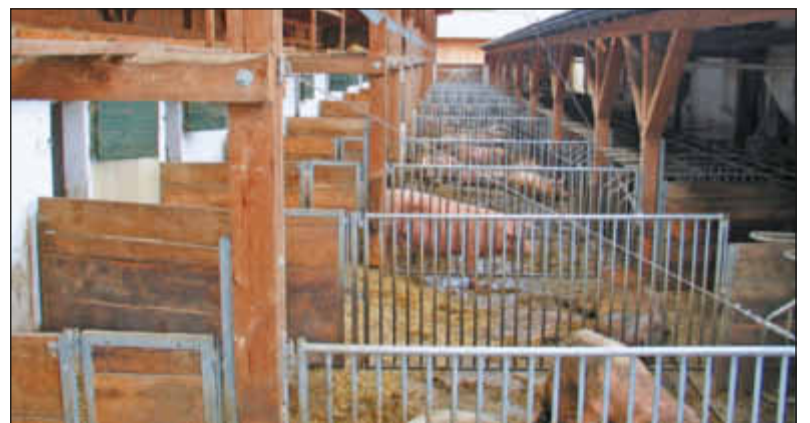
Der mehrhäusige Stalltrakt nimmt die Funktionsbereiche Decken, Warten, Gruppensägen und Ferkelaufzucht auf.
