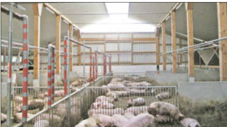
Die innenliegenden Ausläufe im Maststall Glaser sind mit Teilspaltenböden und einer Unterflurschieberentmistung ausgestattet.
