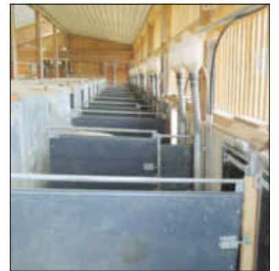
Die Abferkelbuchten: Der Liegebereich (links) ist durch PVC-Streifenvorhänge vor Zugluft geschützt. Die Außenwand hat verschiebbare Spaceboards und selbstschließende Auslauftüren.
