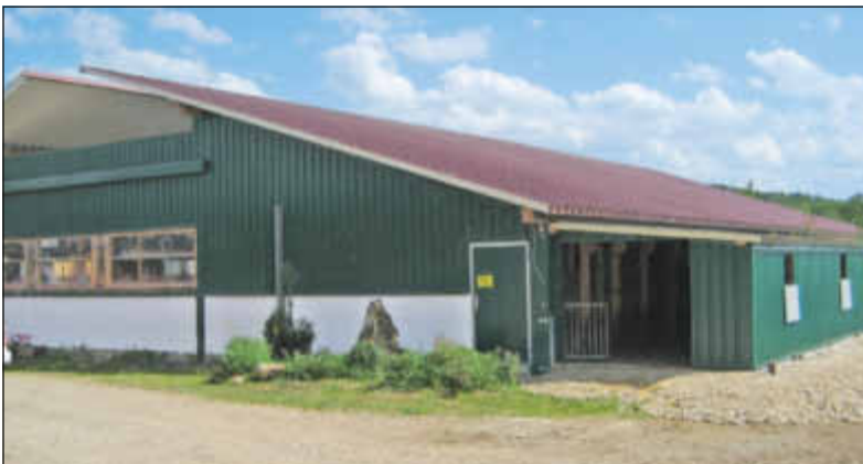
Aus einem ehemaligen Kuhstall entstand der Schweinemaststall mit gegenüberliegenden Pultdächern und innenliegenden Ausläufen.
