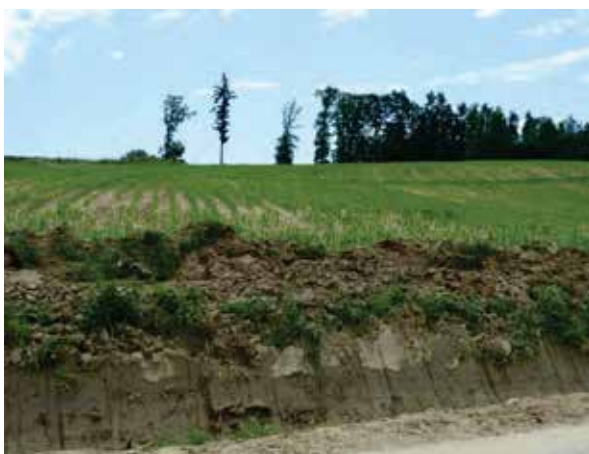
Abb. 13: Erosionsschaden und Erosionsschutzstreifen, 06.06.2011
