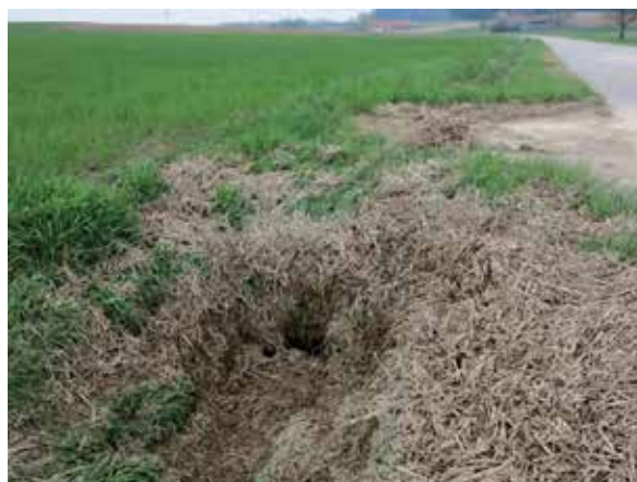
Abb. 47: Mit Senfmulch verstopfter Durchlass, 29.04.2013
