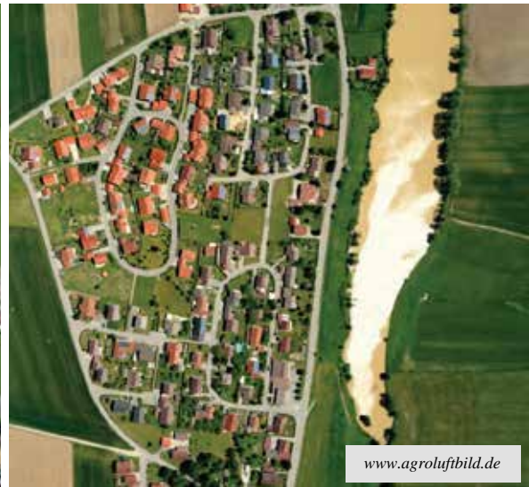
Abb. 16: Iglbachstausee nach einem Erosionsereignis, 18.05.2011
