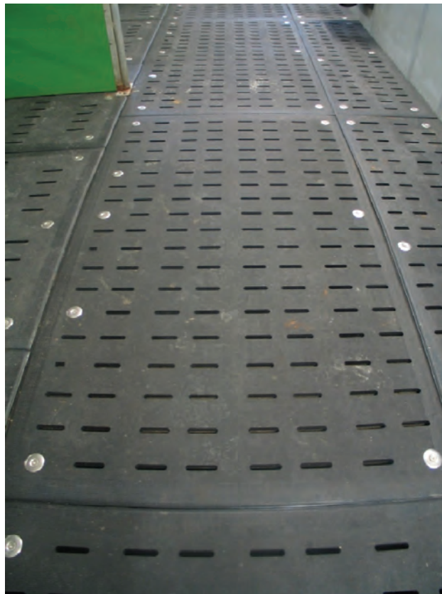
Abb. 20: Geschlitzte Gummimatten auch im Laufbereich werden aktuell geprüft
