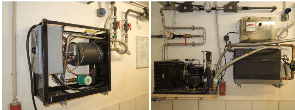
Abb. 17: Vorrichtungen zum Anwärmen (links) und Kühlen (rechts) des Tränkewassers
