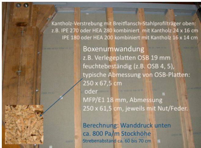
Abb. 4: Ausführung einer Boxenwand.
