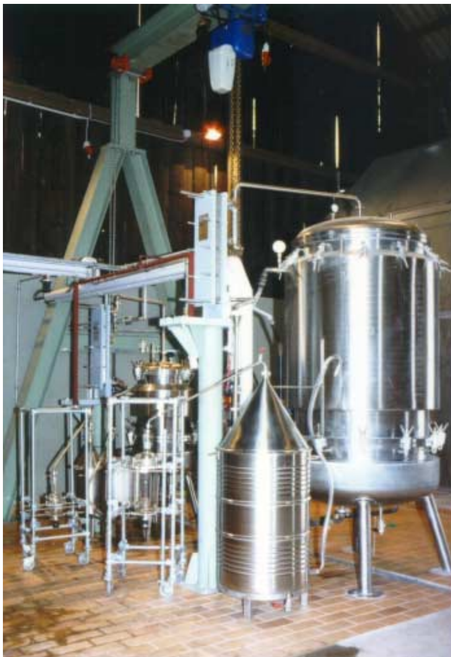
Ausgangszustand der gelieferten Destillationsanlage
