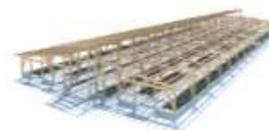
Pilotbetrieb A: Tragwerk in Holz
