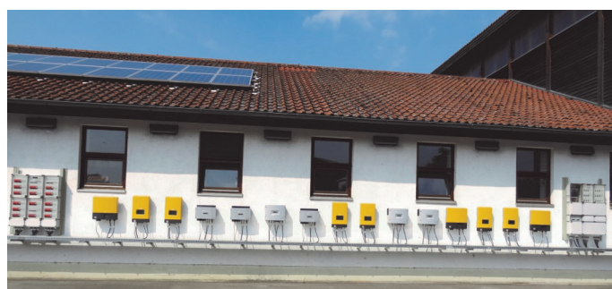
Wechselrichter der einzelnen Modulflächen der Photovoltaikanlage in Grub
