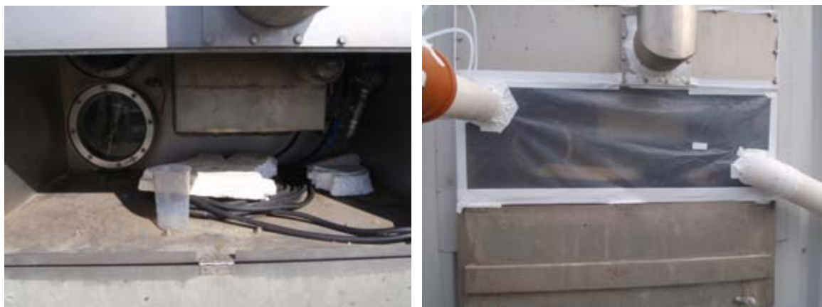
Abb. 1: Praktische Umsetzung einer belüfteten Haube an einem Sichtfenster eines Fermenters
