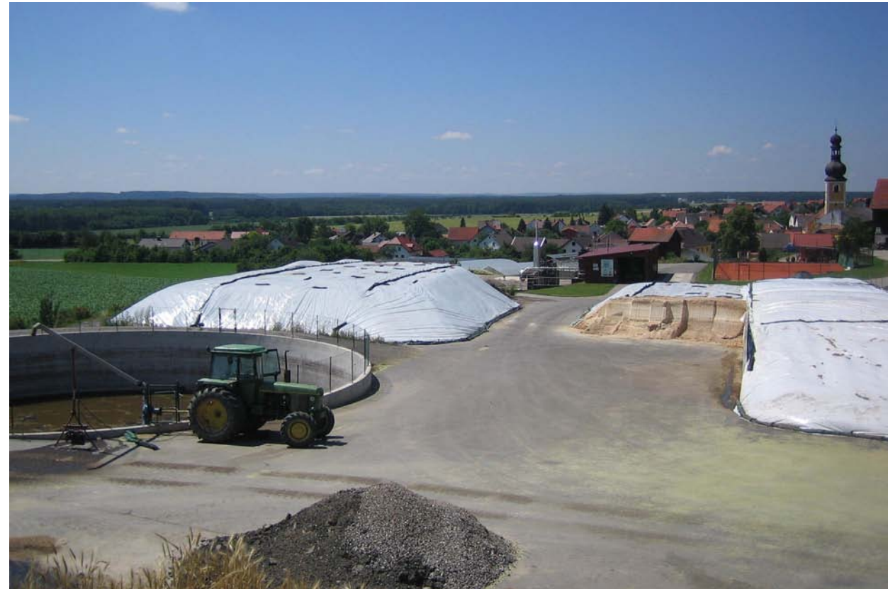
Fahrsilos und Gärrestlager
