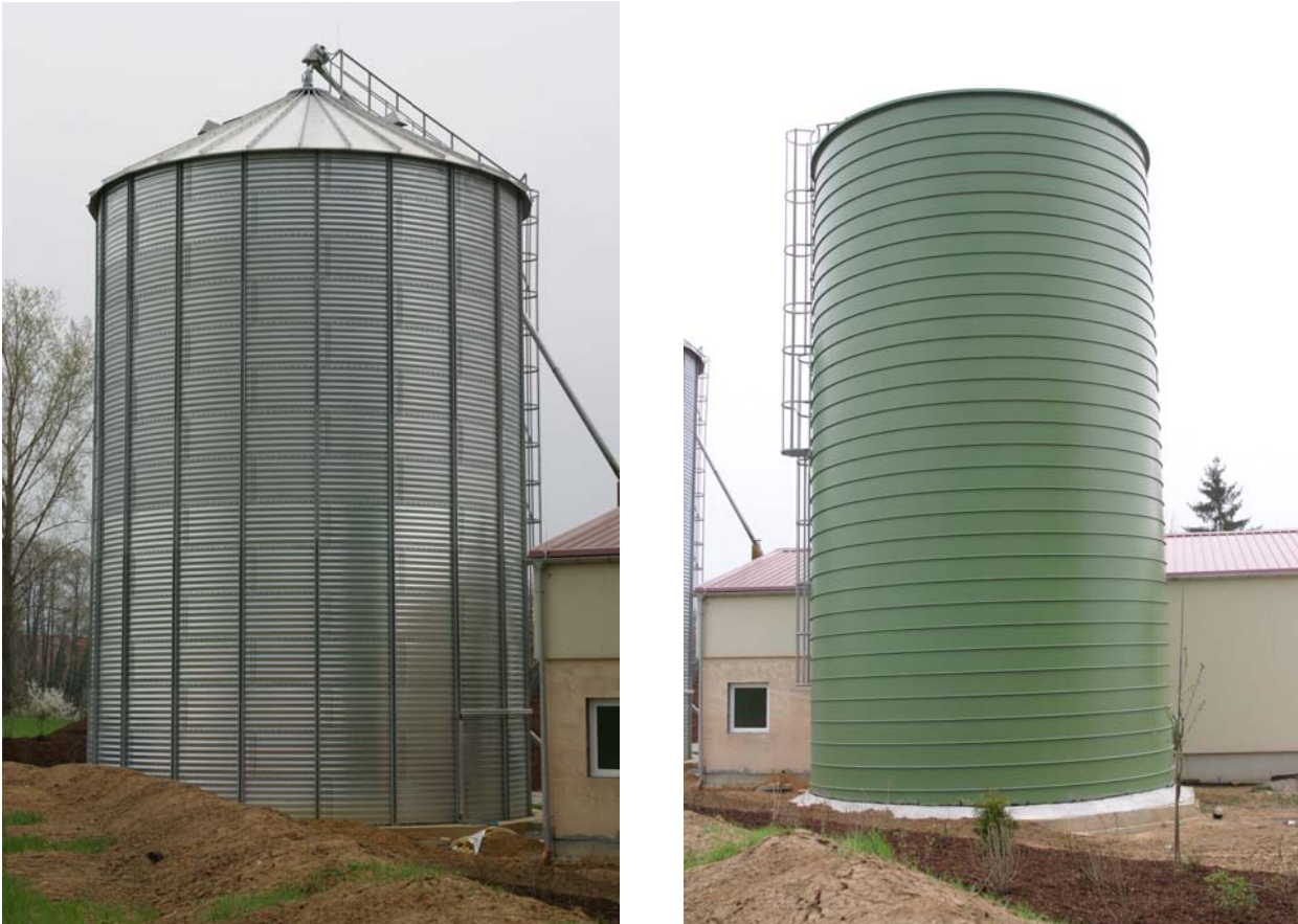
Getreide-Trocken- und Feuchtsilo
