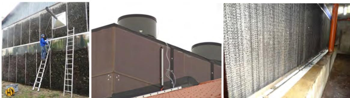
*Geruchsprobennahme mit Haube - Messpunkt Reingas - Säurestufe in 3-stufigem Wäscher*
