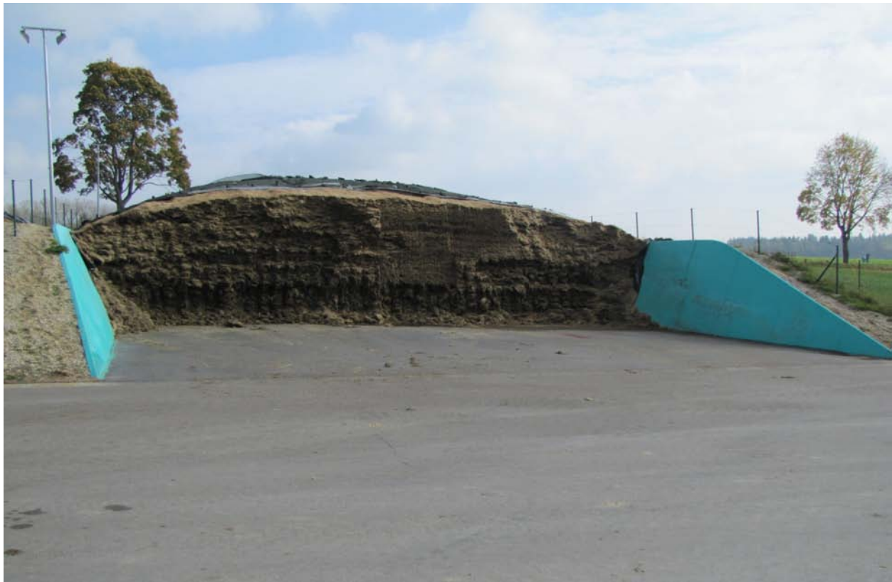
Fahrsilo, Ansicht von vorne
