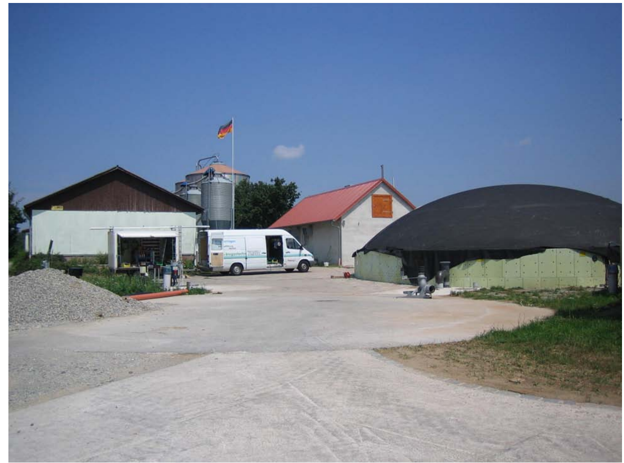
(v.l.n.r.) Schweinestall m. Futtersilos, BHKW-Gebäude, Nachgärer
