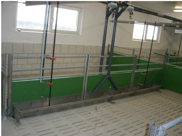
**Abb. 4: Wellnessflüssigfütterung mit Langtrog und Futersensor**
