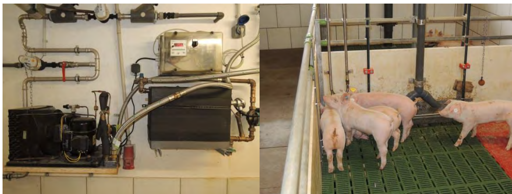
Apparatur zum Kühlung des Wassers und Ferkel mit gekühltem Tränkewasser
