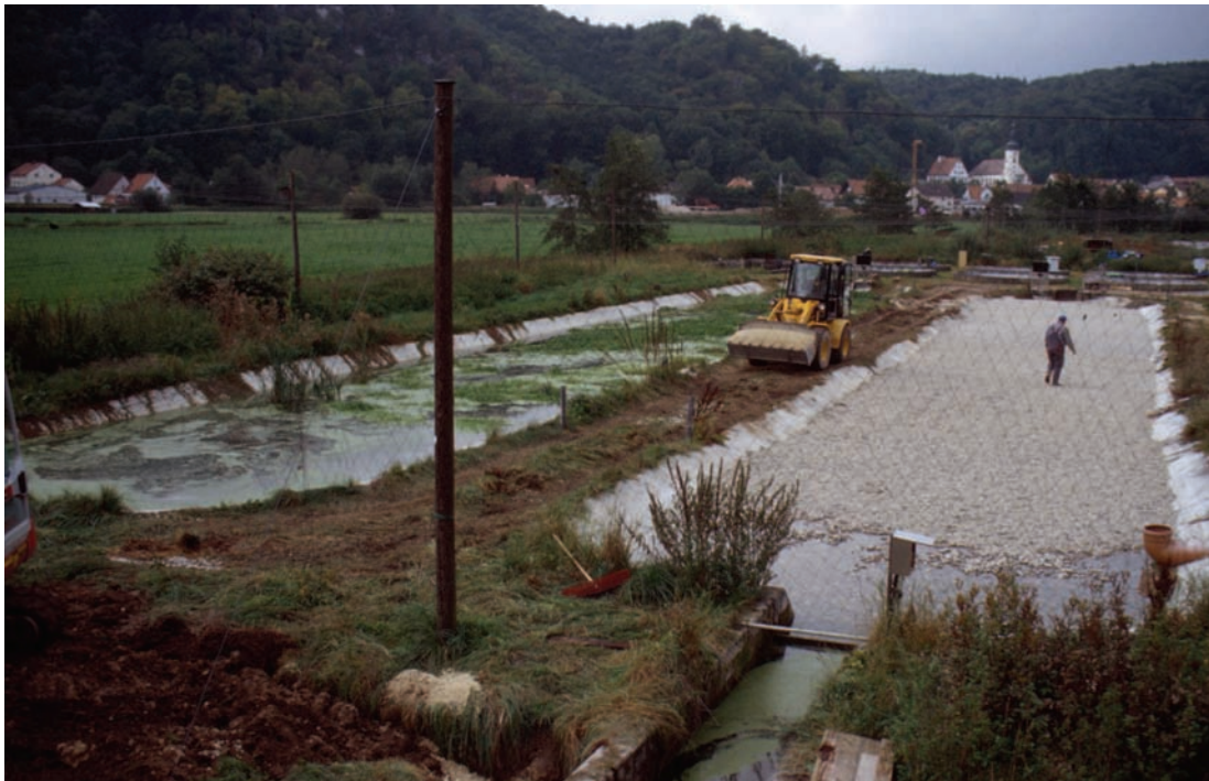
Abb. 13: PKA der Forellenzucht Juraquell zum Zeitpunkt der Fertigstellung (links: PKA nach dem Aquakultursystem, rechts: noch nicht bepflanzte Bodensystem-PKA)
