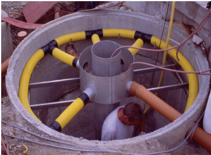
Abb. 20: Dortmundbrunnen in der Fischzuchtanlage Alzgern (während des Einbaus, das Überlaufwasser wird in der gelben Drainageleitung abgeführt)
