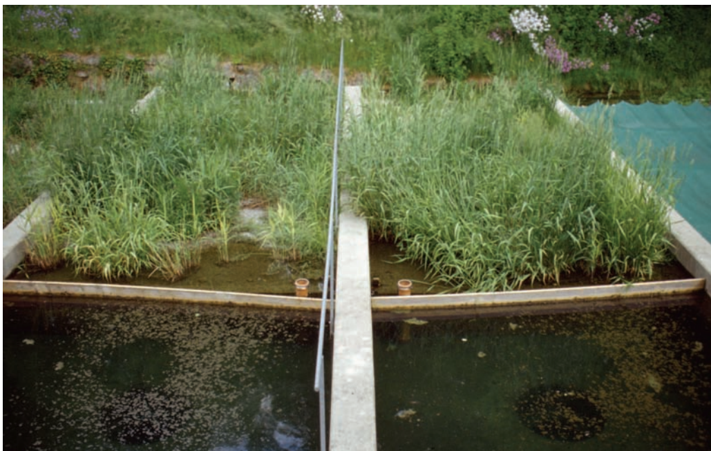
Abb. 9: Pflanzenkläranlage am IFI nach einem Betriebsjahr
