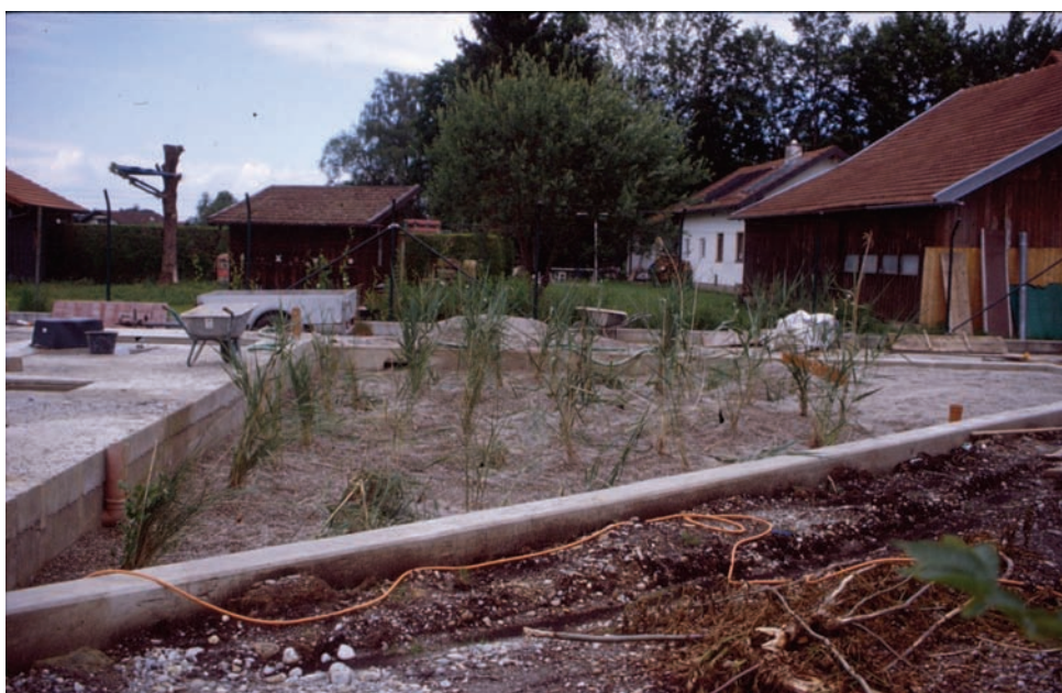
Abb. 23: PKA der Fischzuchtanlage Alzgern zum Zeitpunkt der Inbetriebnahme
