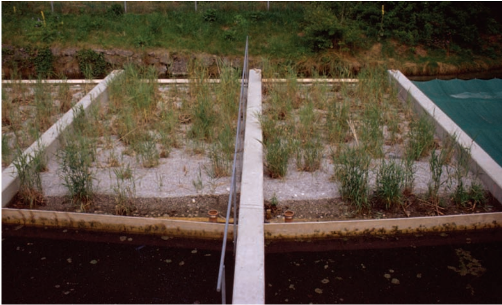
Abb. 8: Pflanzenkläranlage am IFI zum Zeitpunkt der Fertigstellung
