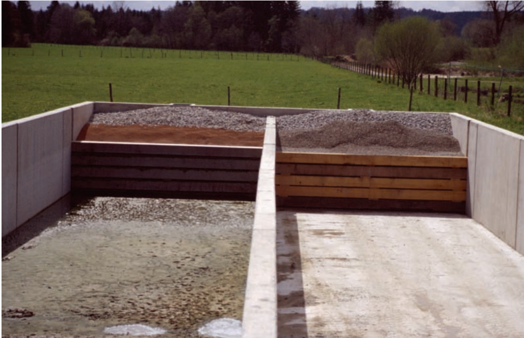
Abb. 1: Absetzanlage der Forellenzucht Aumühle, links Fischgülle in der Abtrocknungsphase, rechts frisch geräumtes Becken
