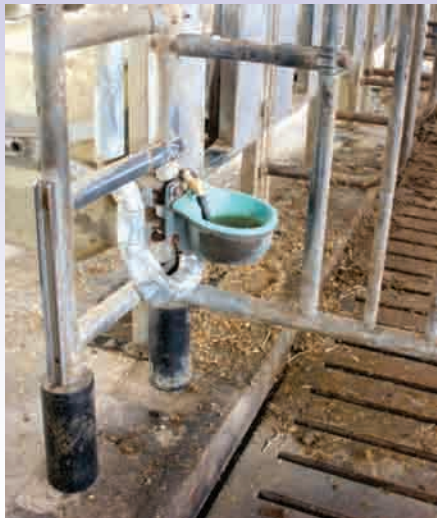
Beheizbares Tränkebecken mit Rohrbegleitheizung
