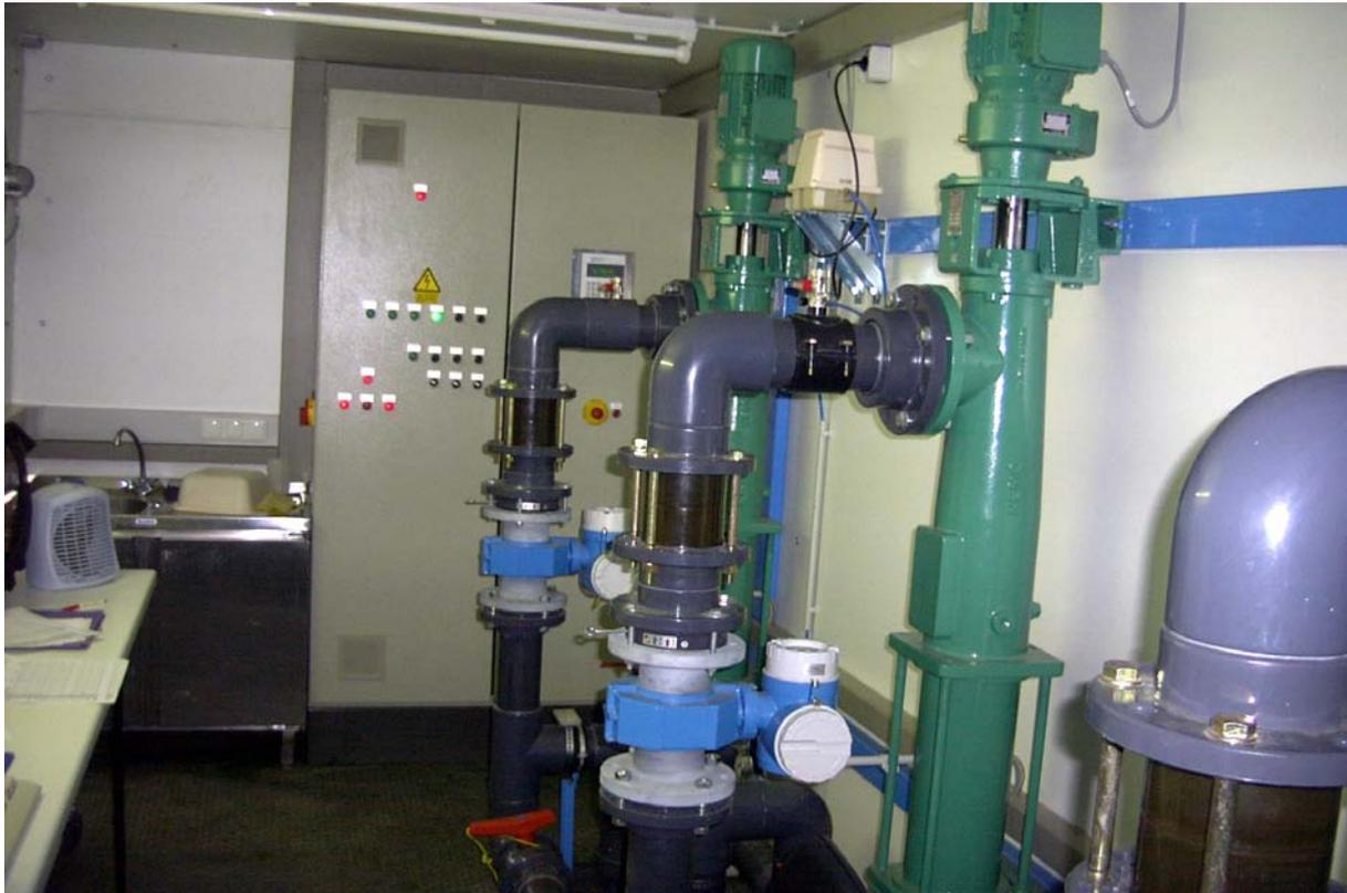
Abbildung 5: Technikcontainer II mit zentraler Schaltanlage (Hintergrund) und Förderpumpen für Gülle
