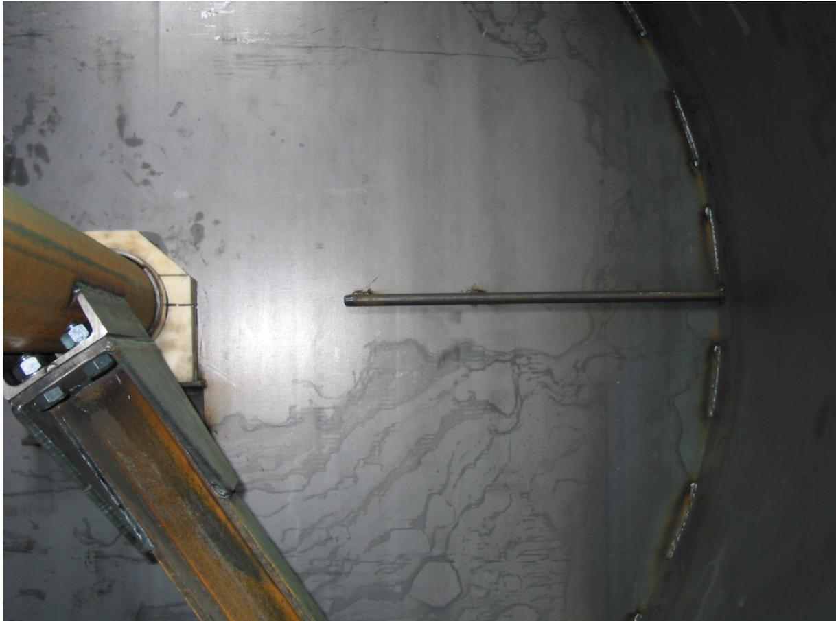
Abbildung 11: Tauchhülse eines der Temperaturfühler an den Schikanenblechen
