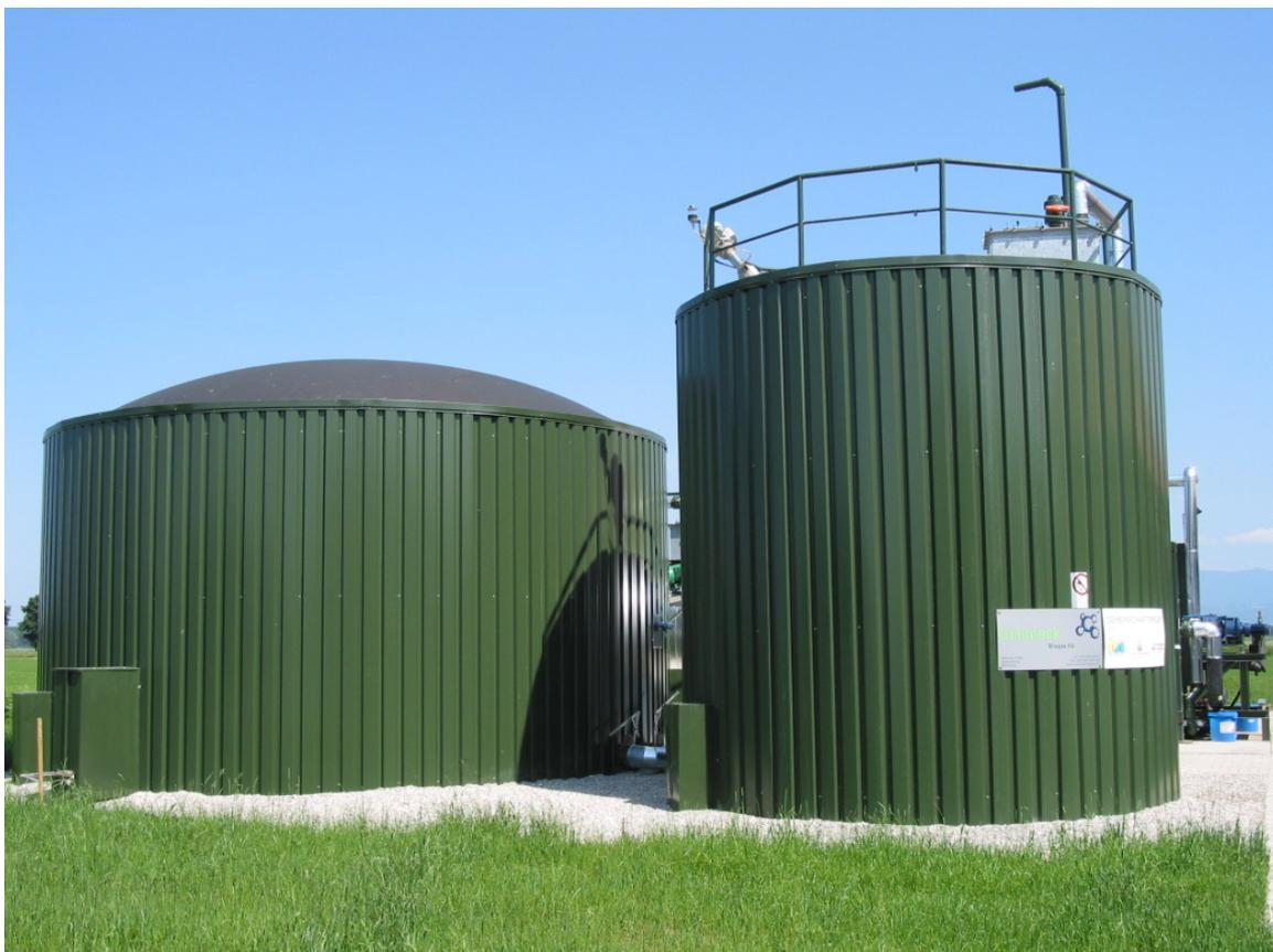
Abbildung 2: Mesophil betriebene Fermenter der Pilotanlage, F1 (rechts) und F3 (links), Blick von Westen
