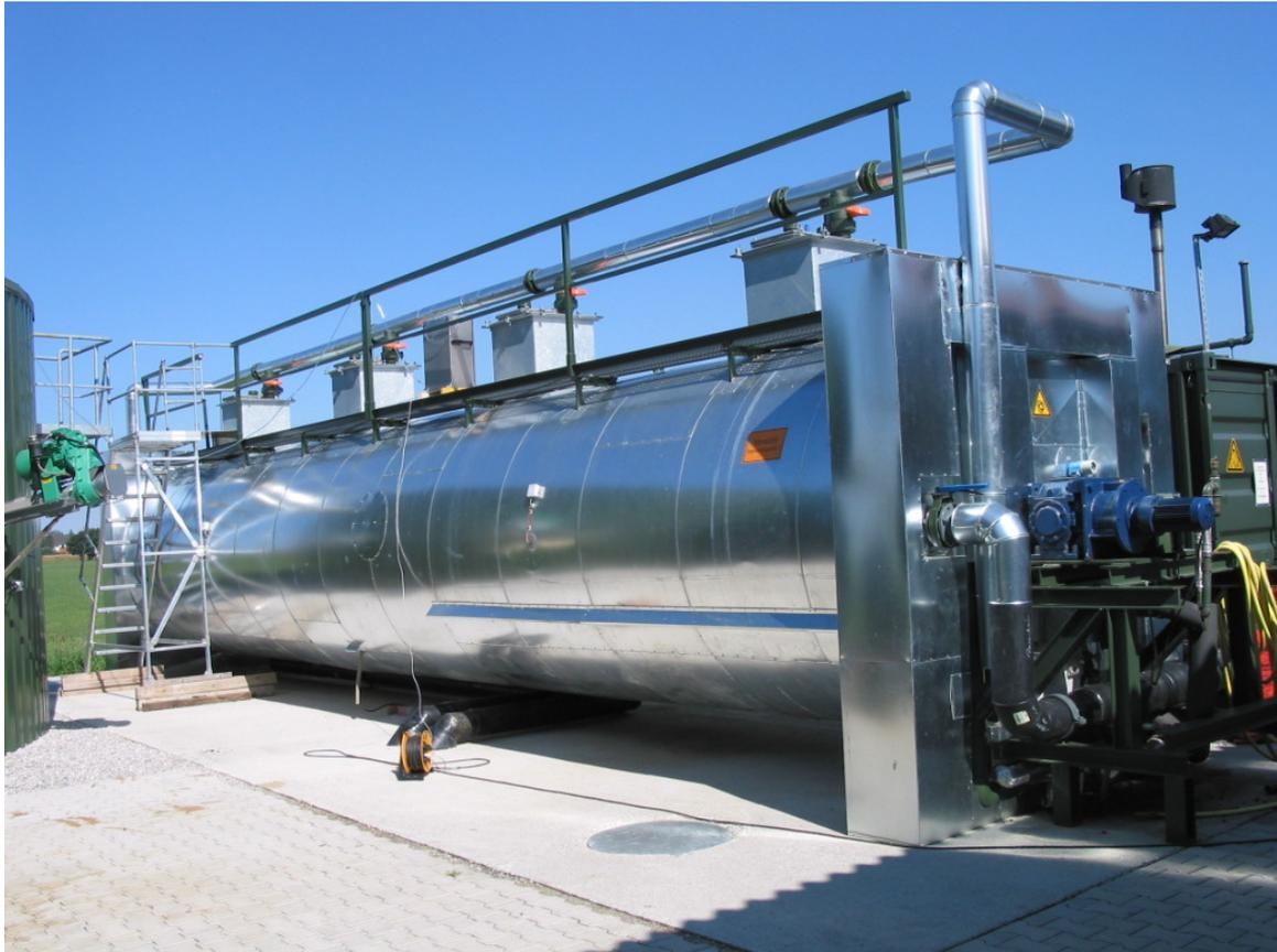
Abbildung 3: Thermophil betriebener Fermenter (F2) der Pilotanlage, Blick von Westen
