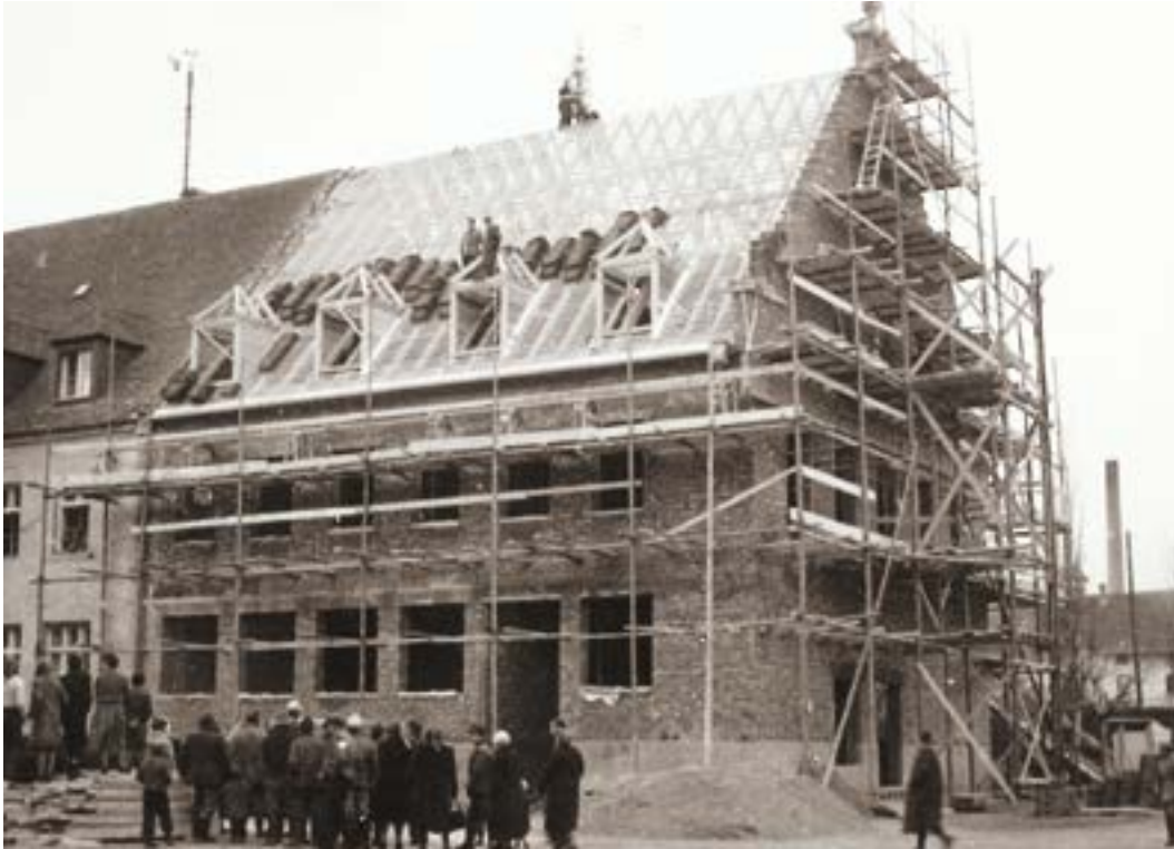
Am 13.12.1957 konnte man ein feierliches Richtfest für den Bau des großen Hörsaals begehen.
