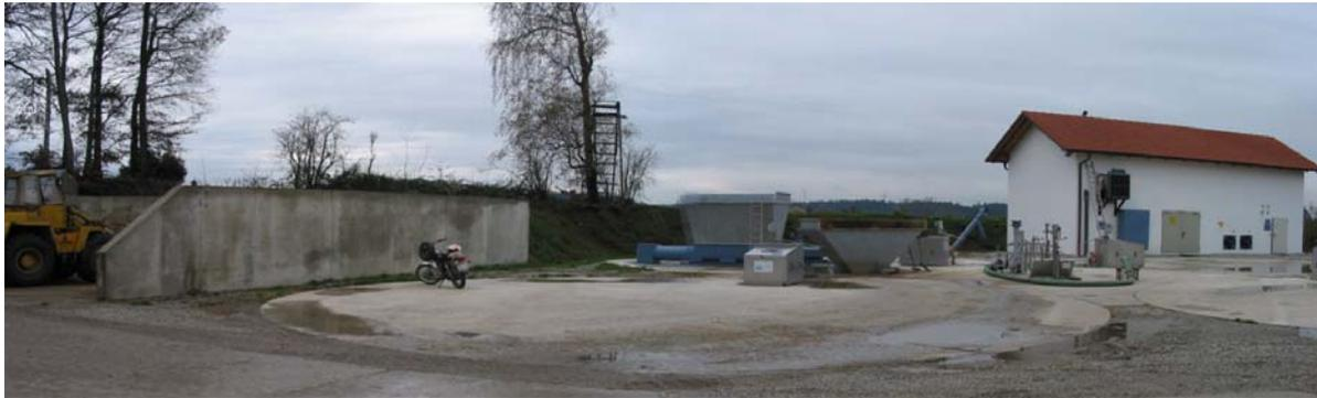
2-stufige Biogasanlage mit Einspülschacht, Feststoffeinbringung, Serviceschacht u. Maschinenraum
