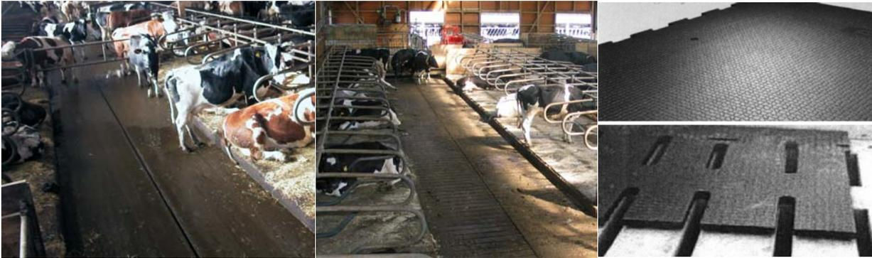
In Milchviehställen werden die Laufflächen meist planbefestigt (Beton, Gussasphalt), mit Betonspaltenböden oder jeweils mit Gummiauflage ausgeführt
