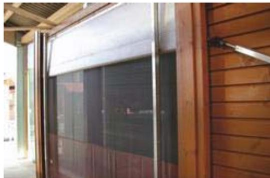
System Wickellüftung, Typ „oben öffnend“ (links) und Typ „unten öffnend“ (rechts) (Abb.: Fa. Wolf GmbH & Co)
