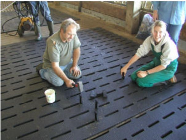
Abbildung 3: Montage der Gummimatten im Laufbereich des Gruber Milchviehstalles durch Mitarbeiter der Versuchsstation Grub
