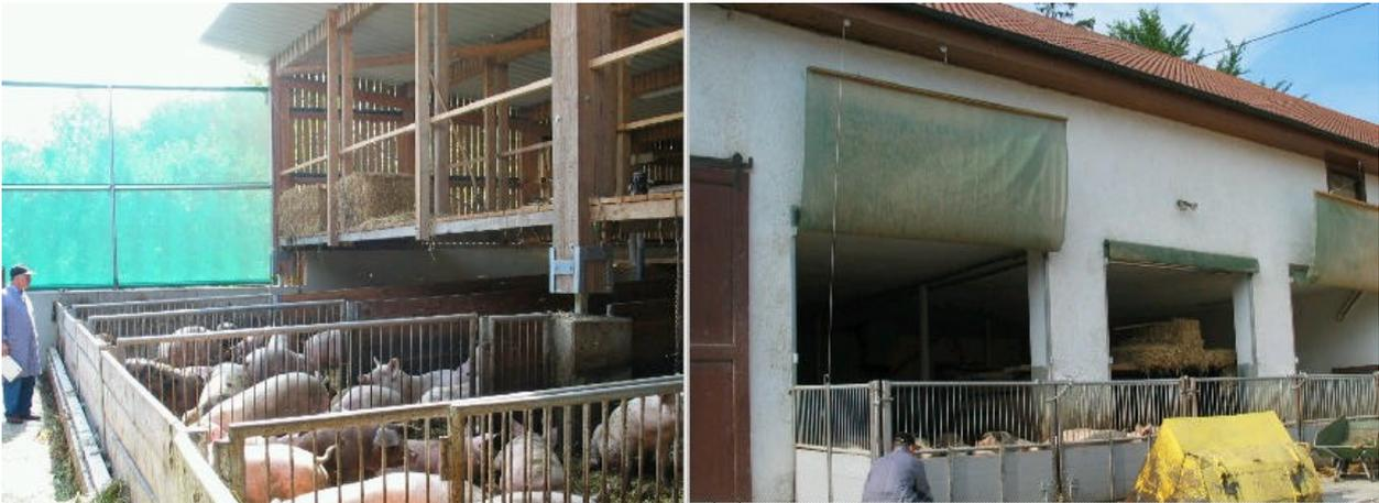
Abbildung 9: Neu gebauter Offenfrontstall für Mastschweine (links), Umbaulösung (rechts)
