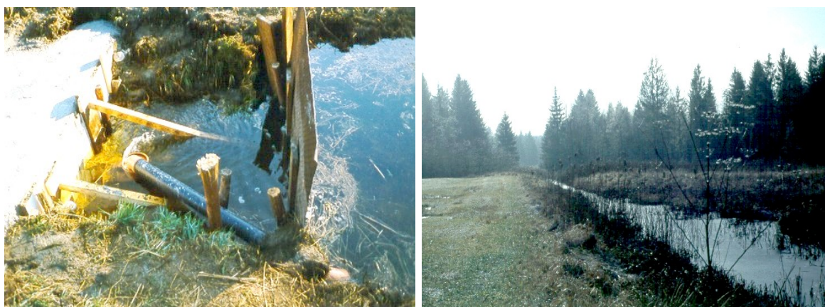
Fertigstellung des Ablaufes mit einbetoniertem Kunststoffrohr (Bild links), der aufgestaute Hauptgraben im Winter 2002/2003 bei normalem Wasserstand (Bild rechts)
