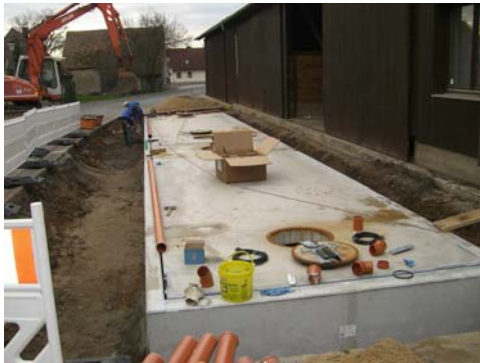
Einbau einer Fuhrwerkswaage in Schwarzenau zur exakten Ermittlung der Güllemengen
