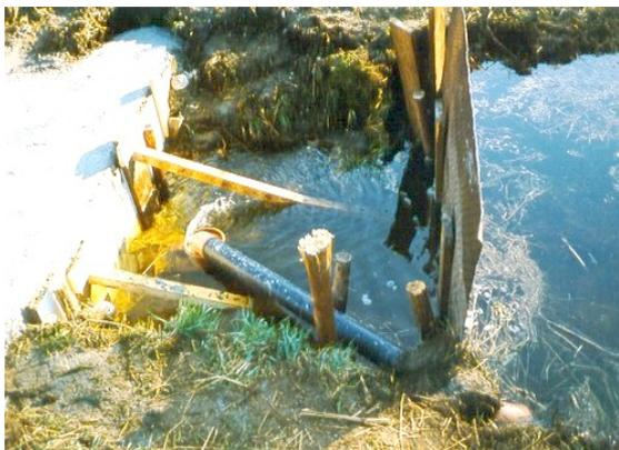
*Fertigstellung des Ablaufes mit einbetoniertem Kunststoffrohr*
