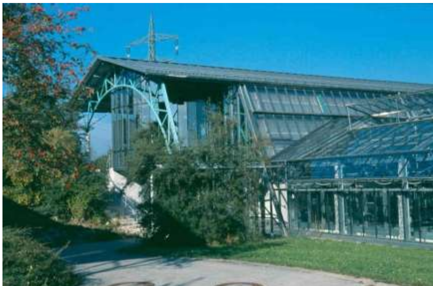
Betriebsgebäude mit Versuchsgewächshäusern
