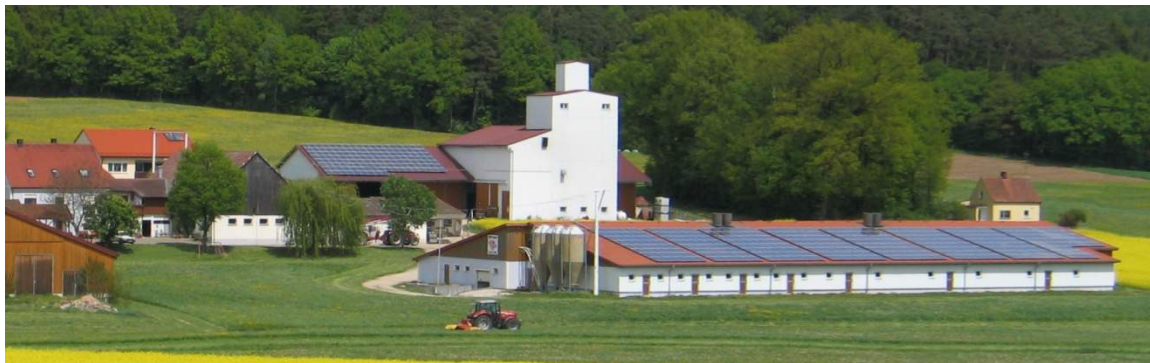
Betriebserweiterung durch neu errichteten Sauenstall an der Althofstelle
