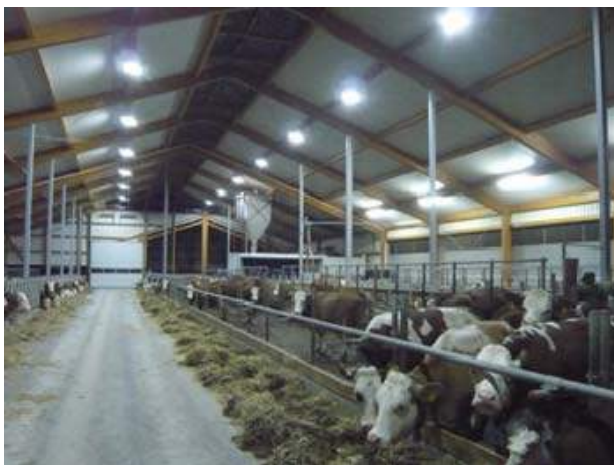
Milchviehstall mit LED-Strahlern
