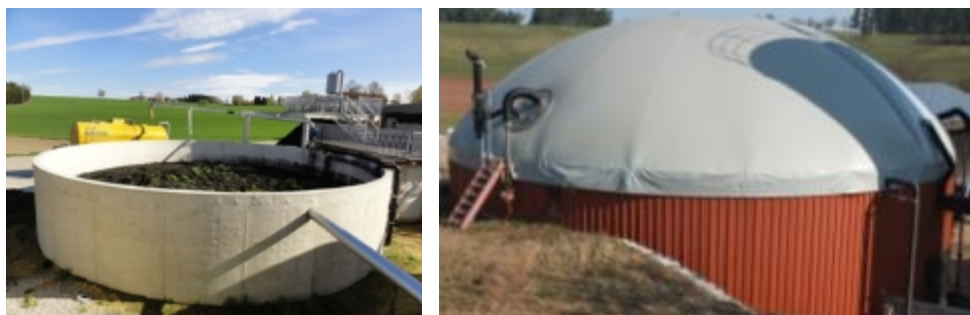
Darstellung eines nicht abgedeckten Gärrestlagers (links), Blick auf ein gasdicht-abgedecktes Gärrestlager einer Pilotbiogasanlage (rechts)
