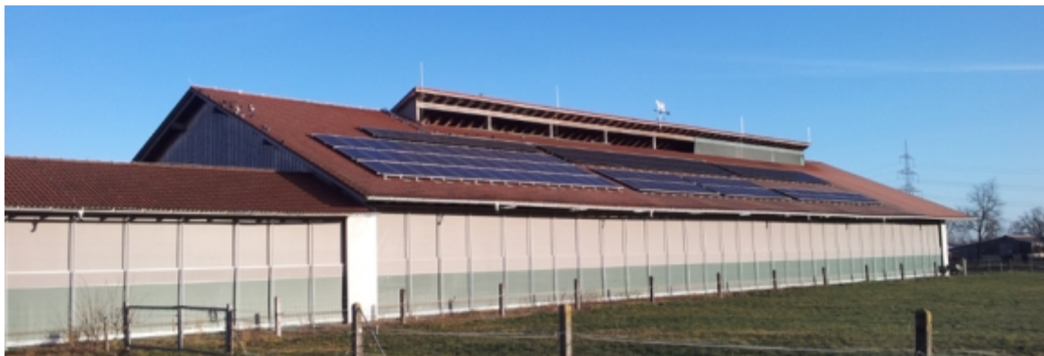
Photovoltaikanlage auf dem Milchviehstall (Südseite) der Versuchsstation Grub
