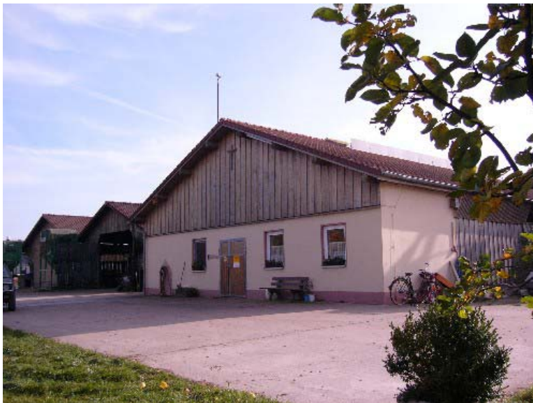
3-häusige Laufstallanlage Bauabschnitt 1 1995 -1997
