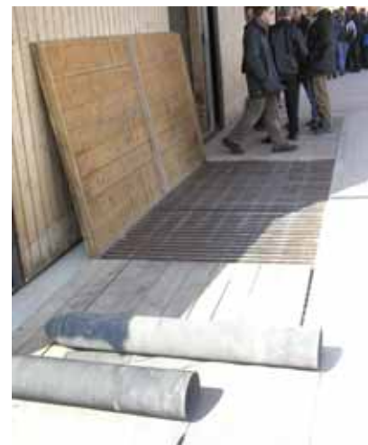
Abb. 2: Lage und Abdeckung einer außen am Gebäude liegenden Annahmegrube
