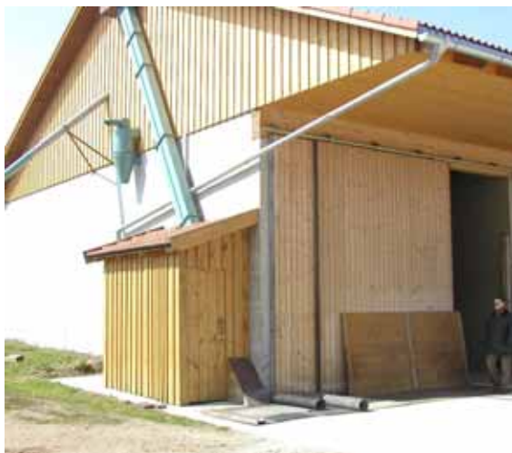
Abb. 2: Lage und Abdeckung einer außen am Gebäude liegenden Annahmegrube
