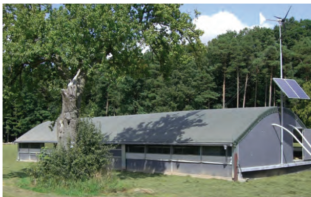
Abb. 1: „Wördekemper Mobilstall“ für 1.000 Legehennen, die Energieversorgung erfolgt durch Wind und Sonne
