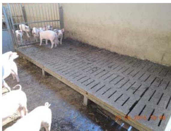
Abb. 17: Schrägbodenställe, bei denen der Entmistungskanal an der Außenwand auf ein Minimum reduziert ist, gibt es in Außenklima- und in Warmställen
