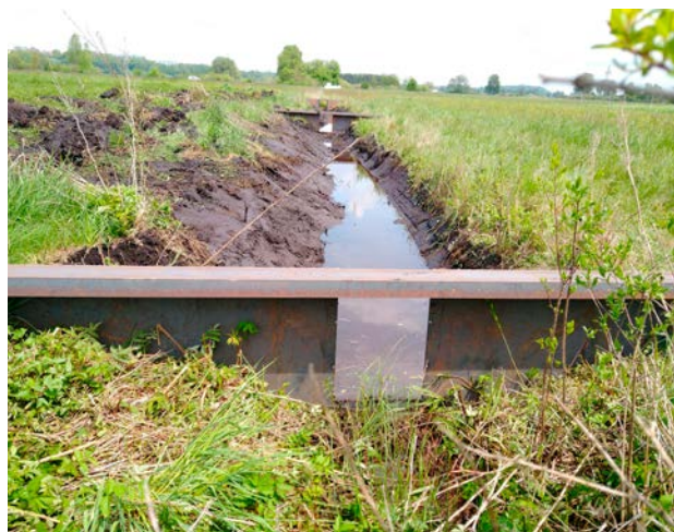
Einbau von Stauwehren im Freisinger Moos.
